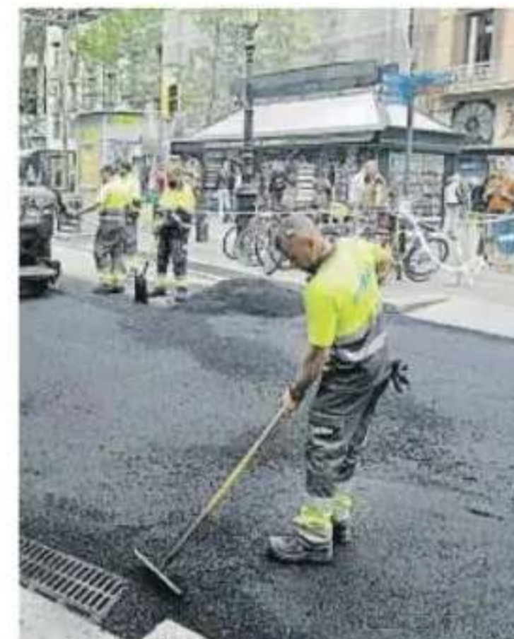
Obras de asfaltado en Barcelona
